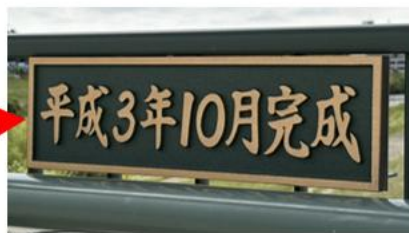
橋名板 (金属製プレート)
