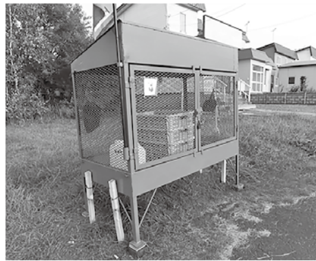
▲資材高騰で塗装作業が中止されたクリーンステーション
