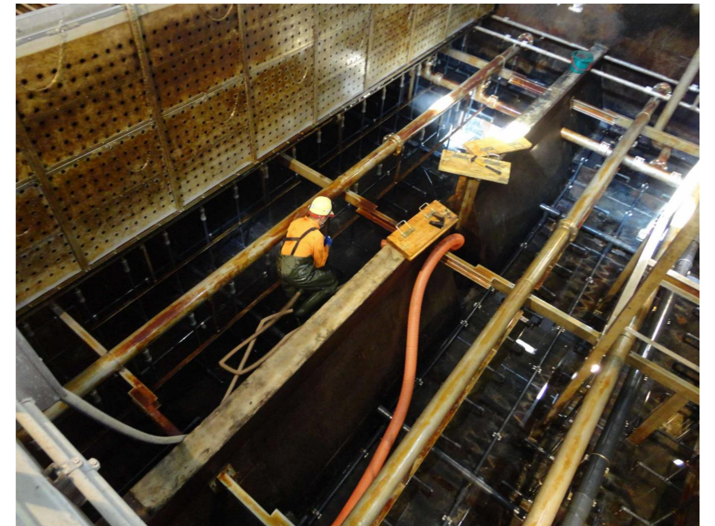
沈殿池定期清掃状況
