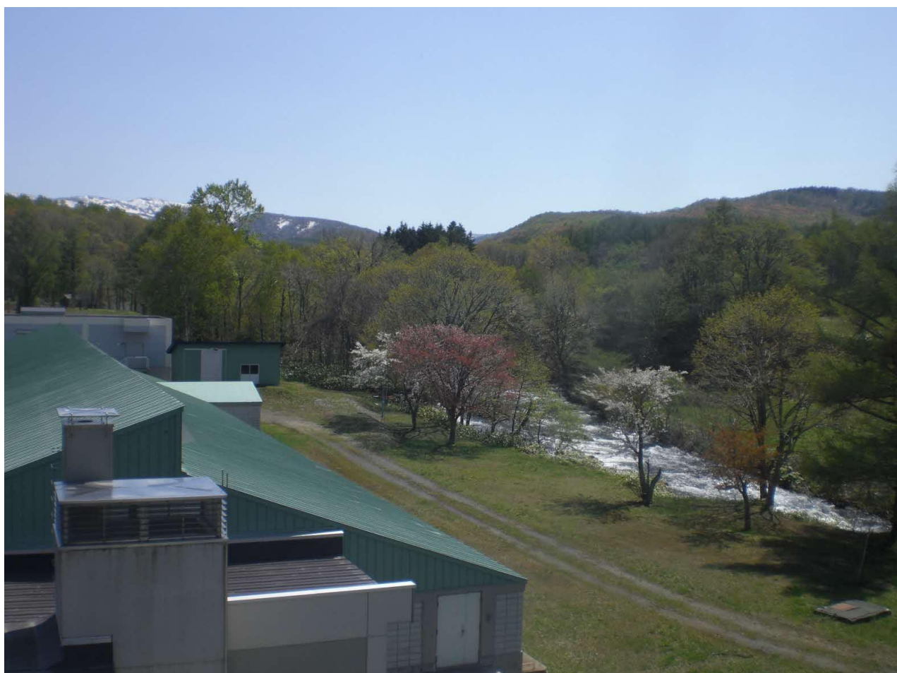
新信砂浄水場 沈殿池棟・新信砂川
