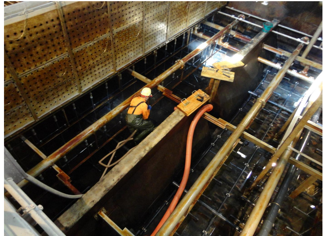
沈殿池定期清掃状況
