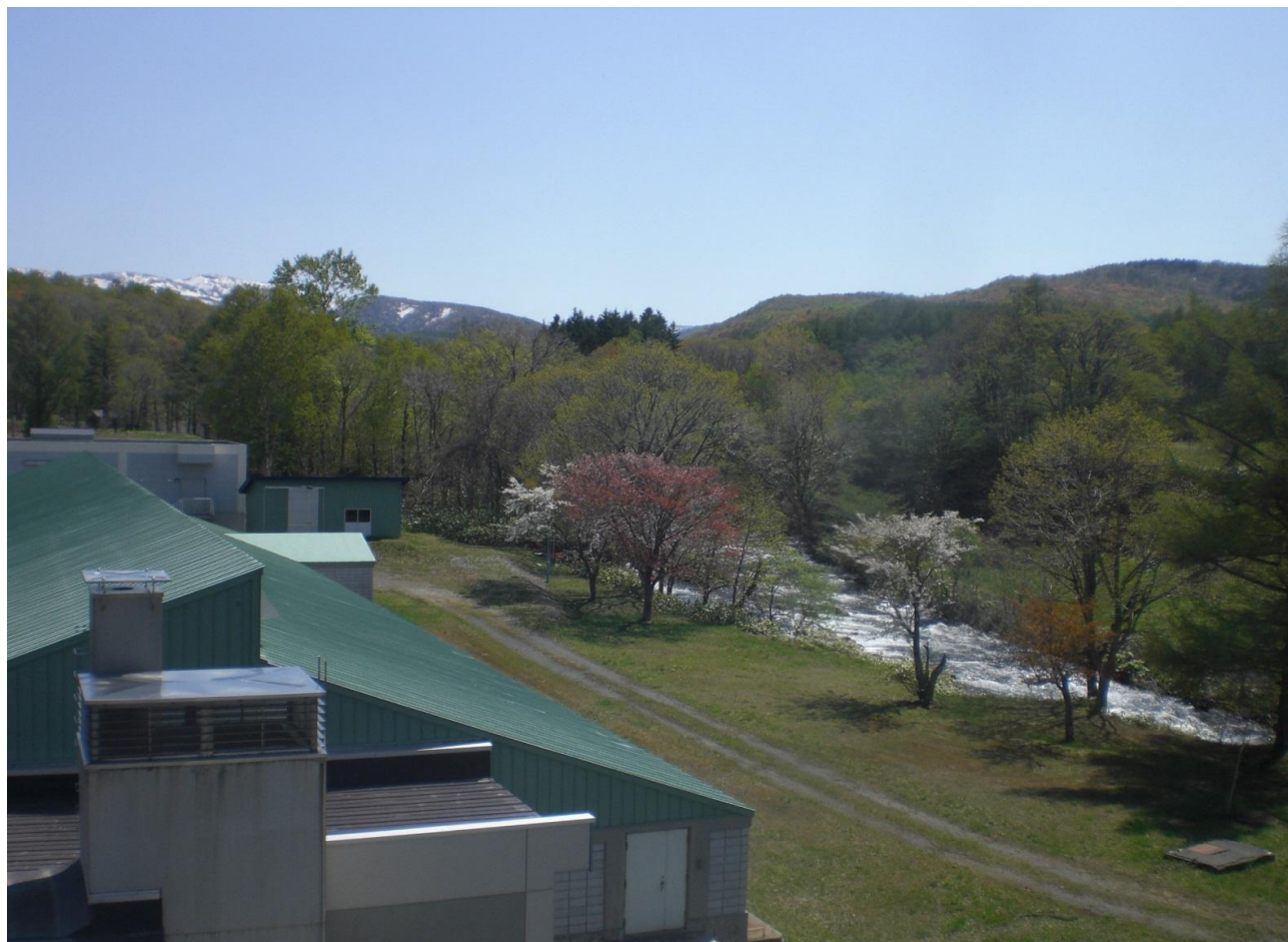
新信砂浄水場 沈殿池棟・新信砂川
