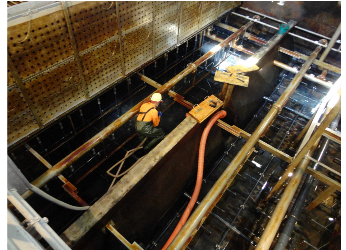
沈殿池定期清掃状況
