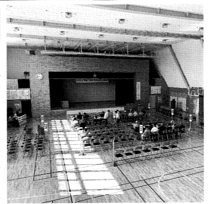
▲地域材を利用した留萌小学校のフローリング
