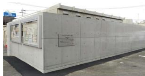
コンクリート壁に囲まれた非常用発電設備 常総市HPより
