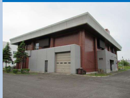
浄化センター
