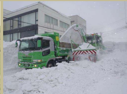
市道における排雪作業
