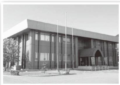
▲留萌浄化センター
