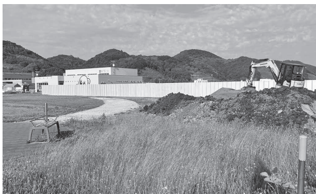
▲アウトドア・アクティビティ拠点施設の工事が始まった道の駅るもい
