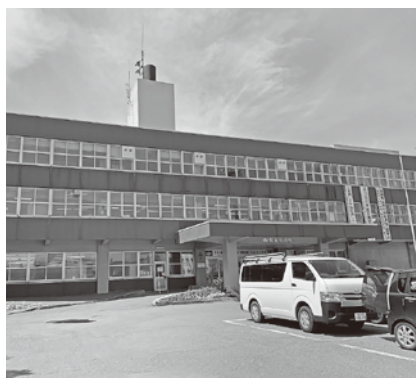
▲建設後62年が経過した現庁舎
