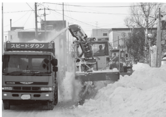
▲運搬排雪や道路拡幅除雪作業の様子
