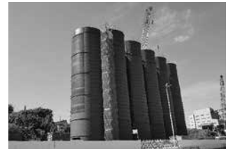
▲建設が進む留萌市小麦集出荷貯蔵施設
