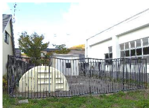
（付帯設備：排水処理棟）
