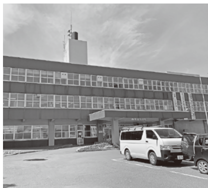
▲建設後62年が経過した現庁舎
