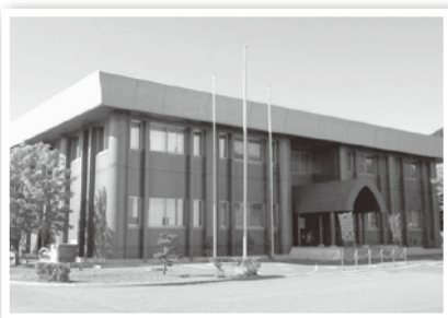
▲留萌浄化センター
