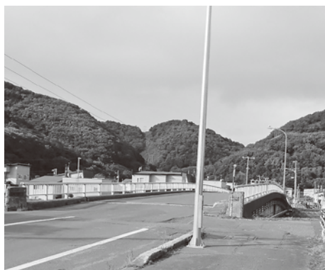
▲大通り橋の今後の改修計画は
