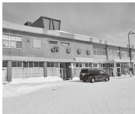
▲新交流複合施設を検討されている (旧)JR留萌駅周辺
