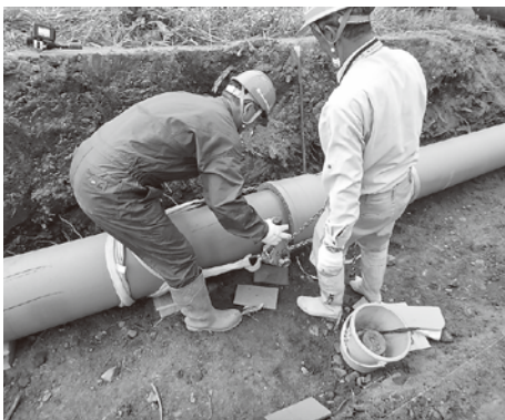
▲水道工事作業の様子
