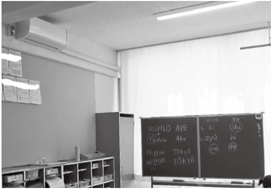
▲空調設備が整備されている教室
