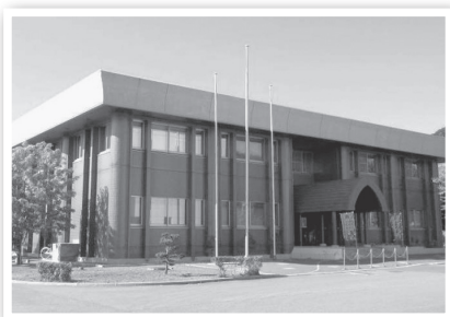
▲留萌浄化センター
