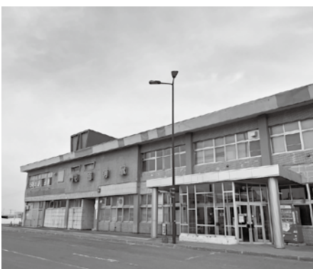
▲複合施設整備が検討される留萌駅舎跡地
