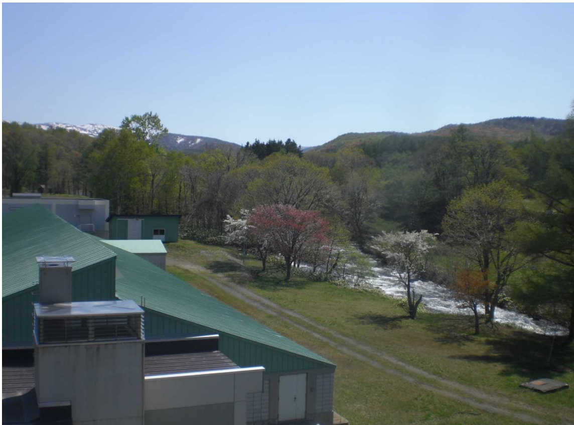
新信砂浄水場 沈殿池棟・新信砂川
