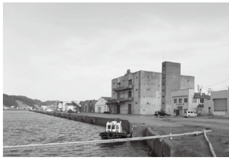
▲現在のバラ化小麦倉庫は、老朽化が著しく、建替整備検討が進んでいる。
