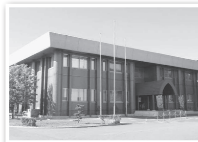
▲留萌浄化センター
