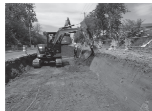
▲市内の道路整備
