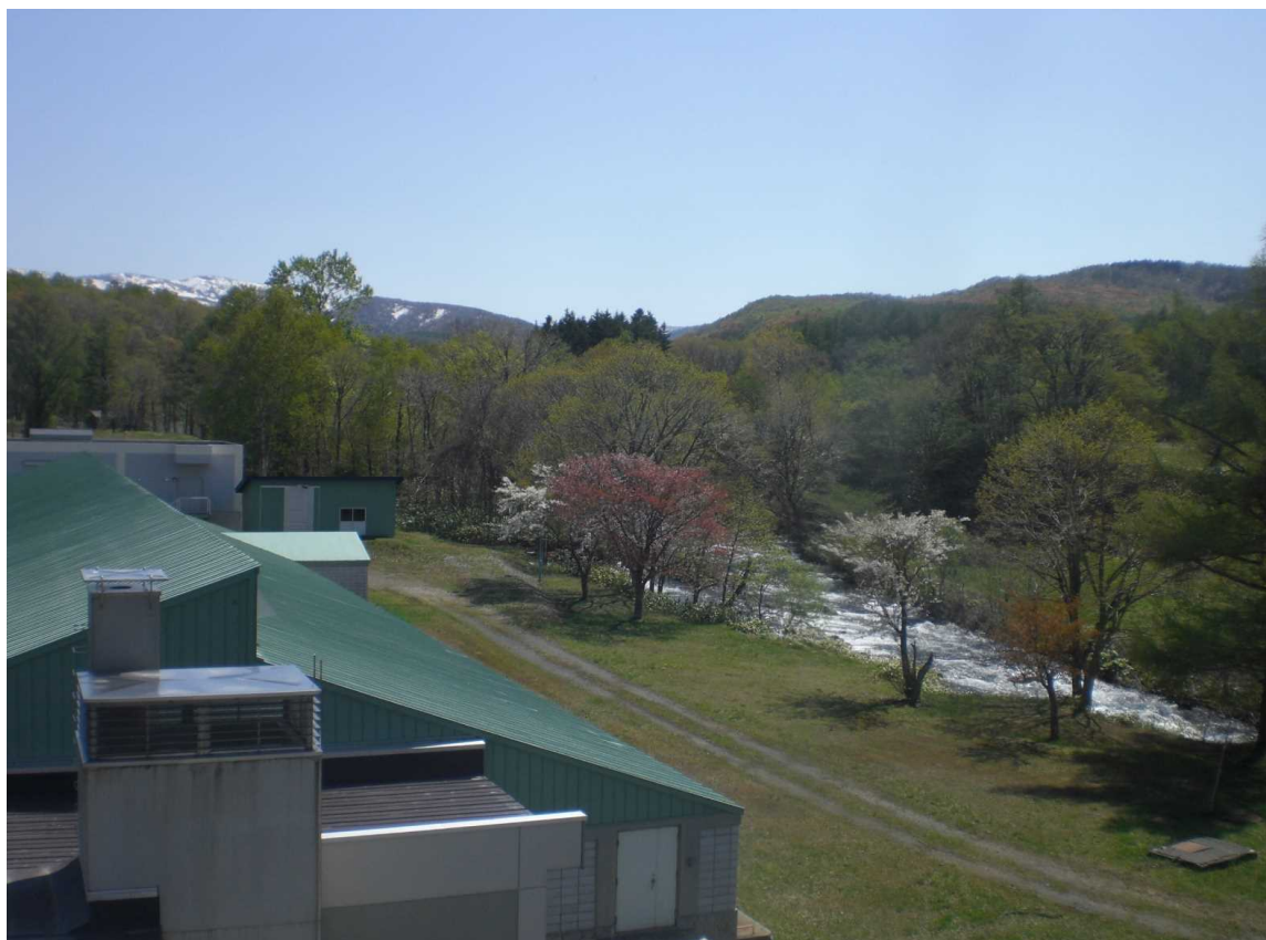
新信砂浄水場 沈殿池棟・新信砂川
