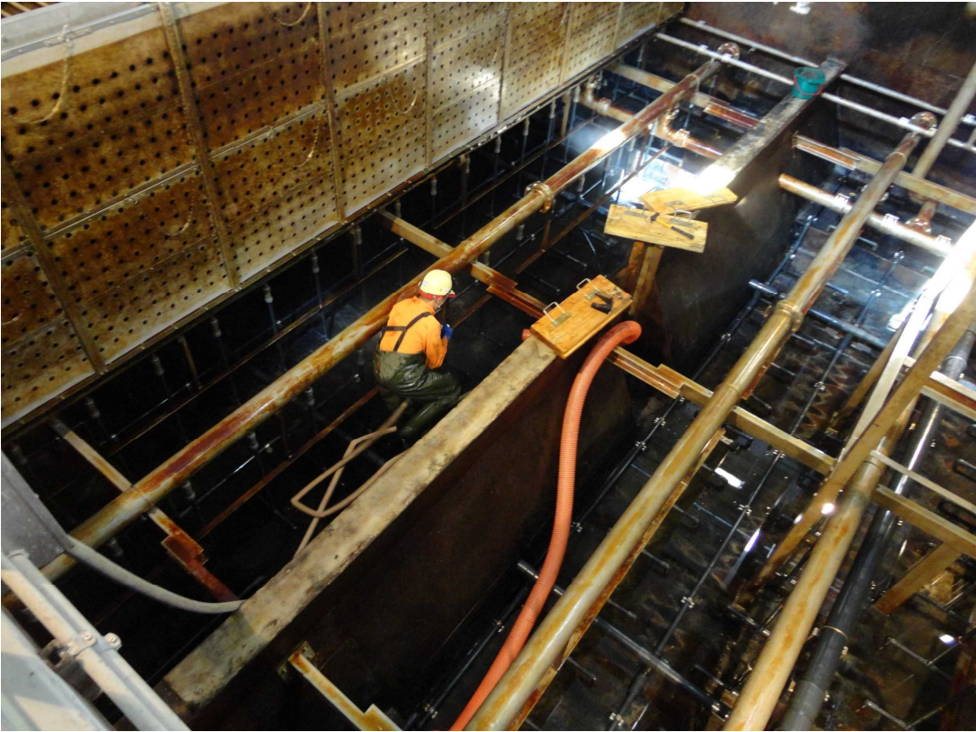
沈殿池定期清掃状況
