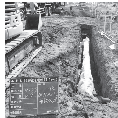
▲配水管工事作業風景
