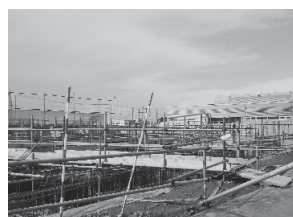
▲建設中の屋内遊戯施設
