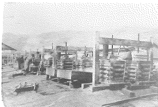
鯨絞め粕作り (鯨釜で煮た鯨は絞め胴に入れられ、压榨される。下から油と水が流れだし、魚油と水を分離し、魚油となる。絞め胴で压榨された鯨は玉と呼ばれ、砕かれて乾燥させ、魚粕となる。)
