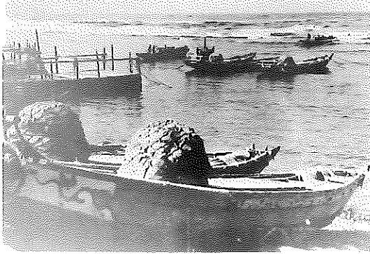
定置網を建てる直前の漁船 (栈橋が造成されている。)
