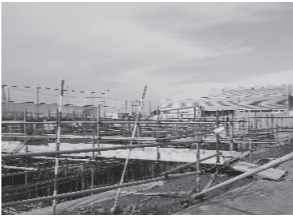
建設中の屋内遊戯施設
