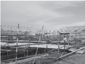
建設中の屋内遊戯施設
