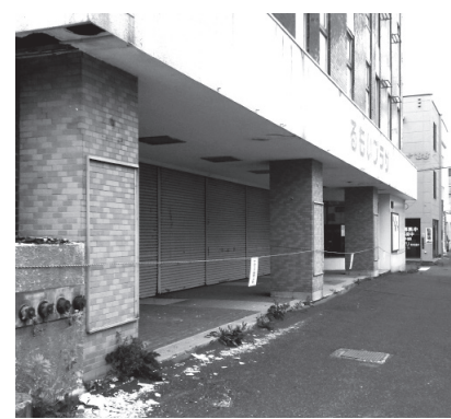
▲入口の天井壁はく離で立入禁止措置になっている旧るもいプラザ
