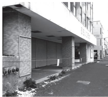
▲入口の天井壁のはく離で立入禁止措置になっている旧るもいプラザ
