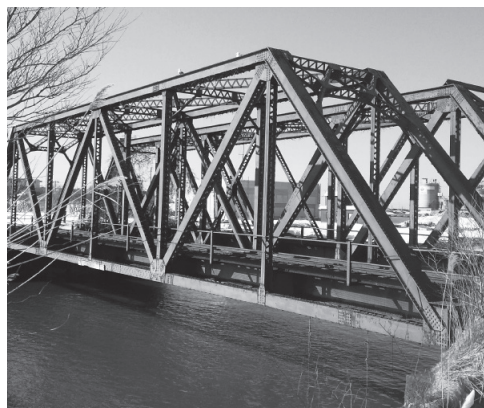
▲安全性などを確認し、補修保存が可能か検討される留萌川橋りょう
