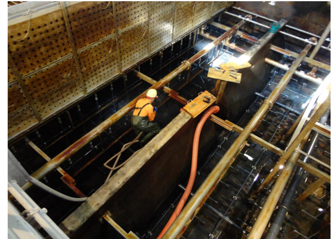
沈殿池定期清掃状況
