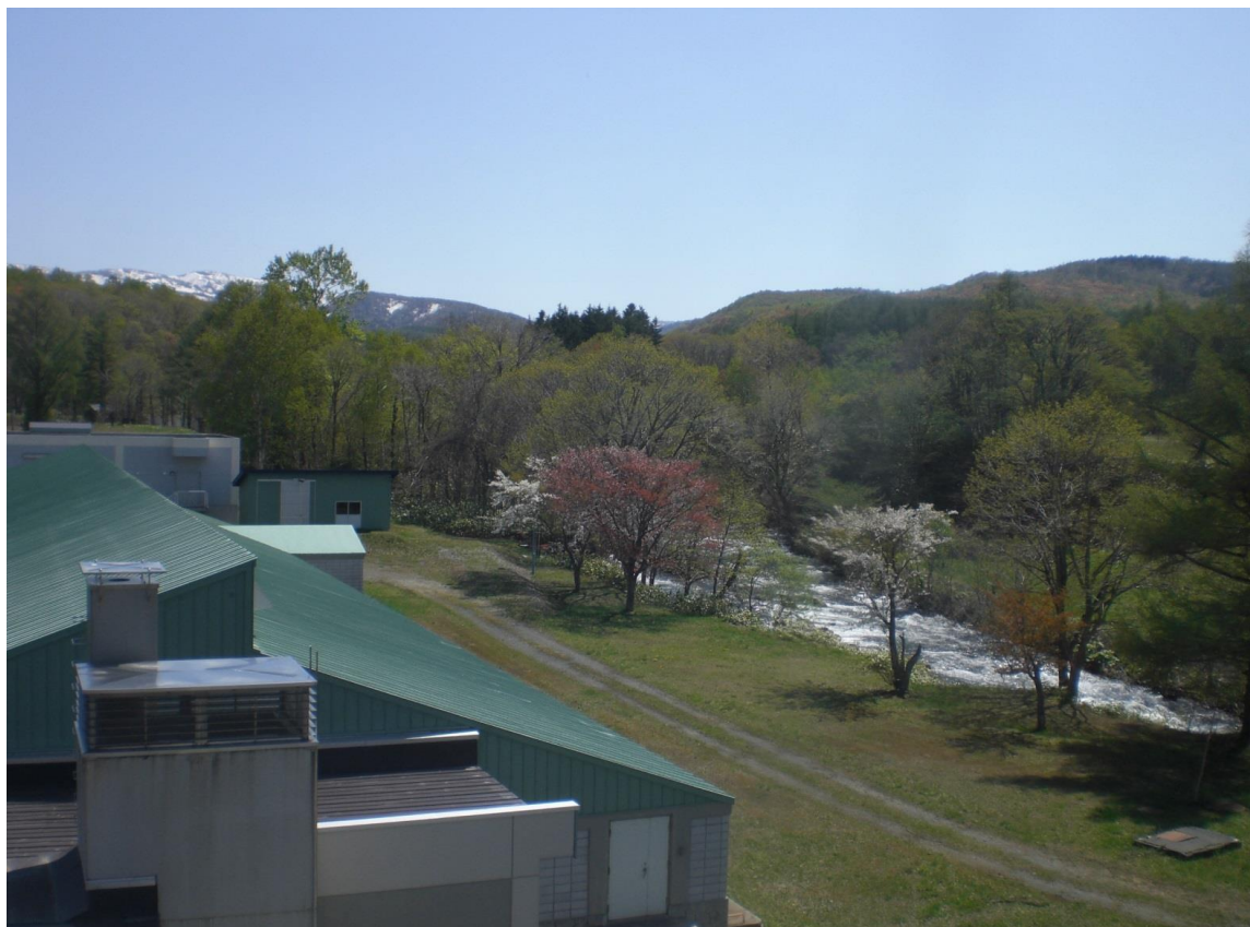
新信砂浄水場 沈殿池棟・新信砂川
