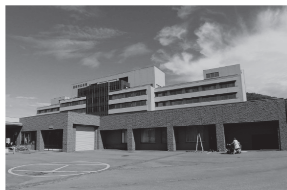
▲感染者患者通用口改良工事中の市立病院
