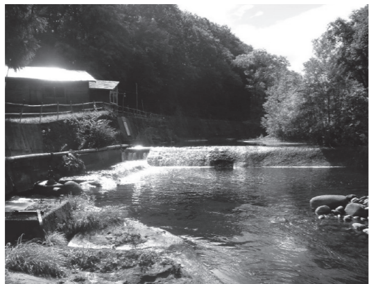
▲新信砂浄水場新信砂川取水口付近
