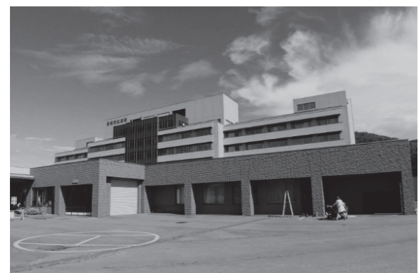
▲感染者患者通用口改良工事中の市立病院
