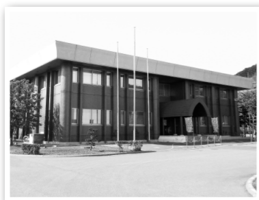
▲留萌浄化センター
