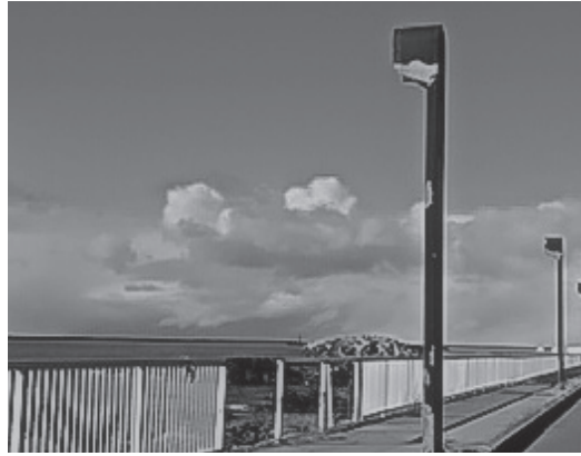
▲老朽化が進む黄金岬ライトアップ設備
