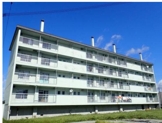
大町 <改良住宅>
