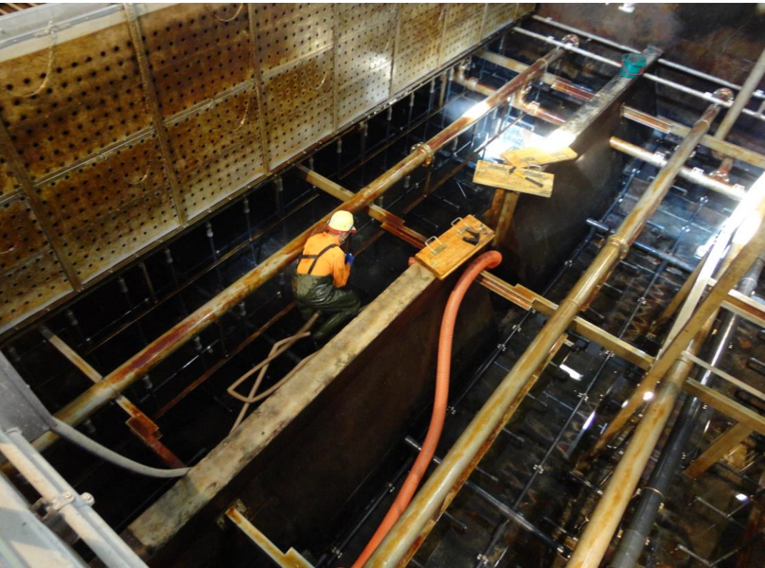
沈殿池定期清掃状況
