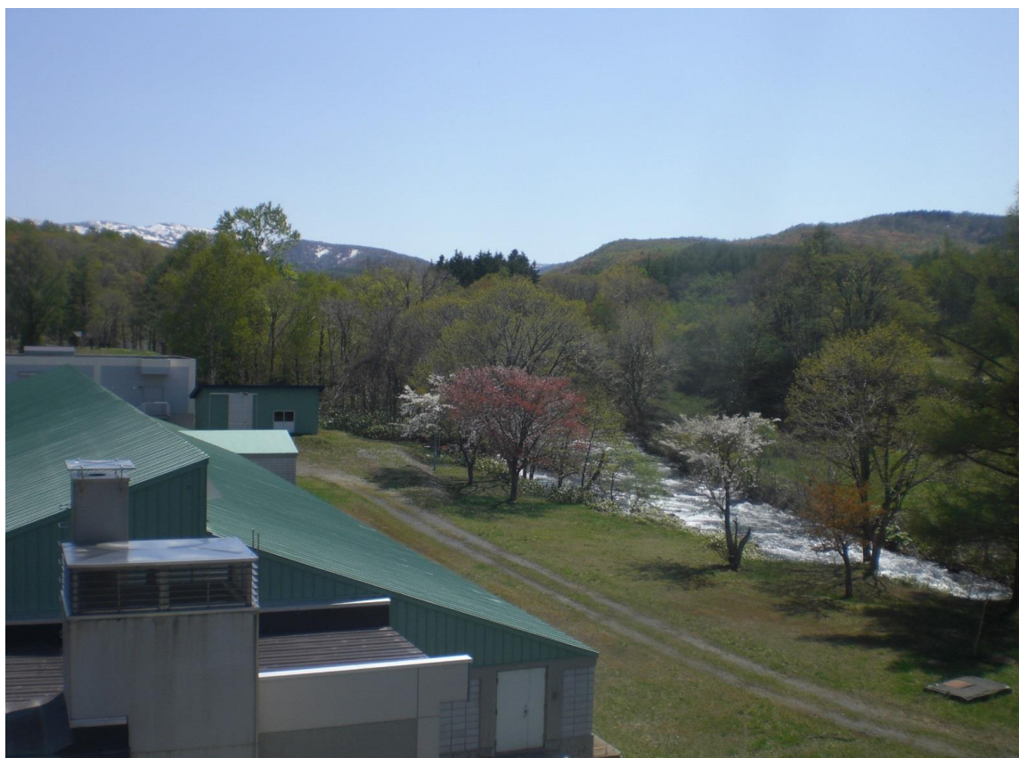
新信砂浄水場 沈殿池棟・新信砂川
