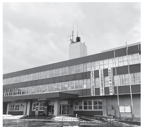
▲震度6強で倒壊の危険がある、市役所庁舎
