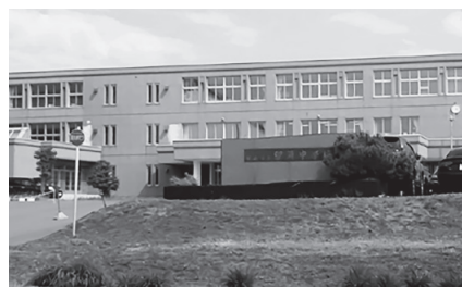
▲大規模改修が行われる留萌中学校の校舎
