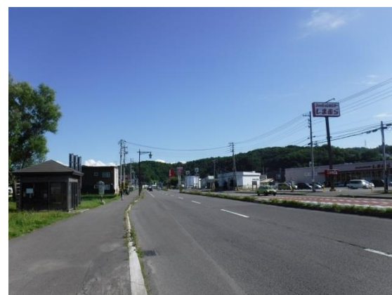
国道233号東橋交差点付近
