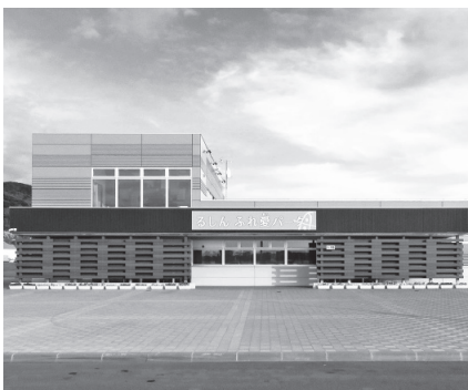
▲「道の駅」の登録に向けた協議が進む 船場公園管理棟
