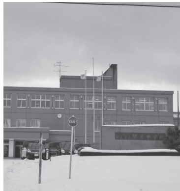
▲大規模改修が行われる留萌中学校
