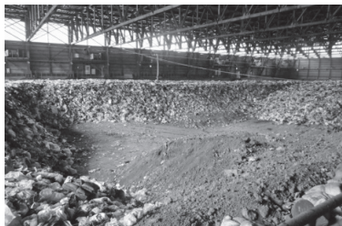
▲不燃系埋立区画の覆土後の様子
