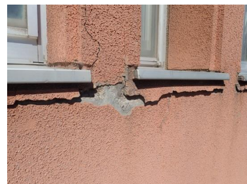
塗装のわれ・はがれ (劣化度D)
