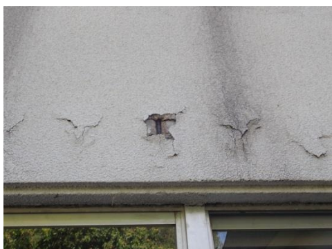
鉄筋の腐食に伴った剥落 (劣化度C)
