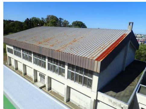
錆・塗装のはがれ (劣化度D)
