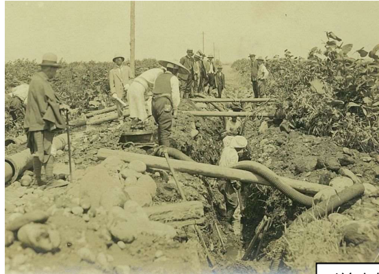
送水管φ250 布設
