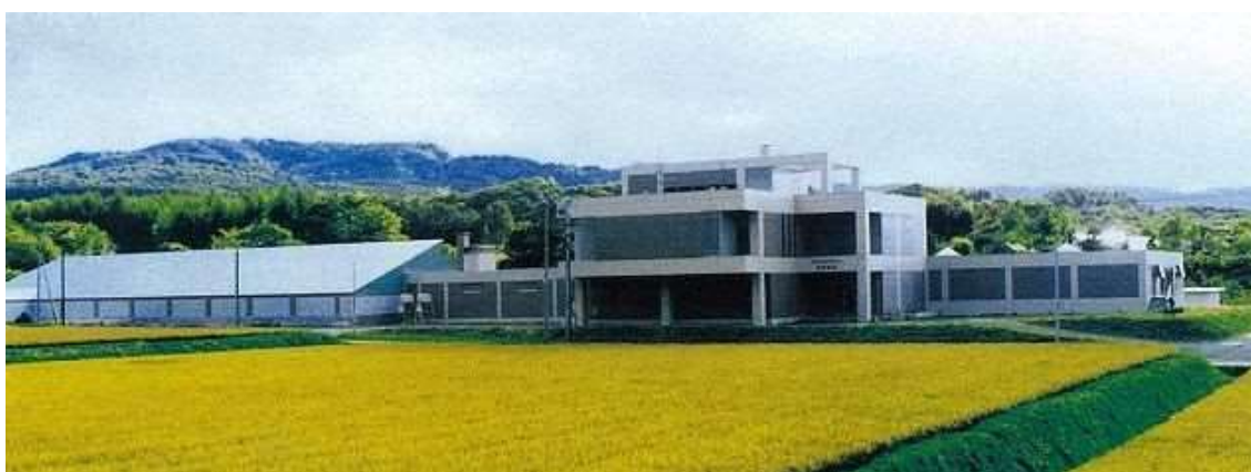
新信砂浄水場
