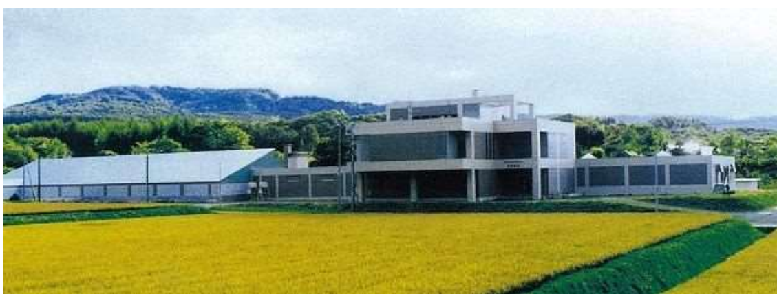
新信砂浄水場
