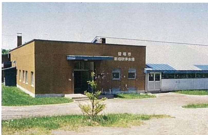
新信砂浄水場
