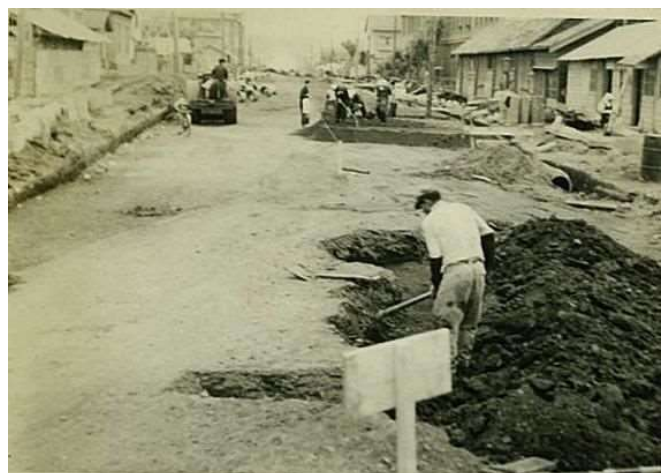
市内配水管布設
