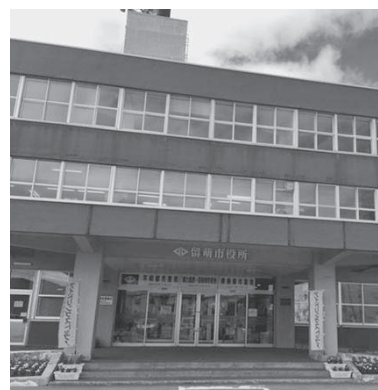
▲老朽化が進む市役所庁舎
