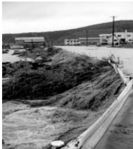
昭和63年の集中豪雨による留萌川氾濫で、汚泥の堆積や土砂崩れが発生しました。住家被害では、床上・床下浸水の数が3367棟、3710世帯に達しました。
